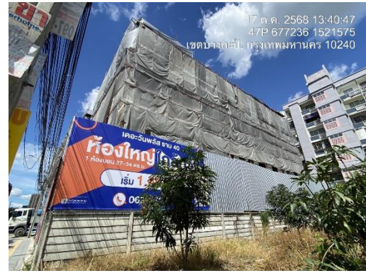
รูปที่ 24 ติด Mesh Sheet
